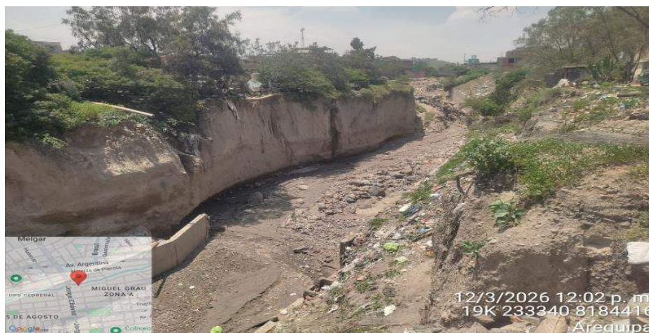
IMAGEN 01: SE OBSERVA LA MARGEN DERECHA QUE REQUIERE DE DESCOLMATACION SE TIENE LA BASE DEL MURO EROSIONADO PARA DEMOLICION Y CONTRUCCION DE MURO Y EVITAR LA POSIBLE AFECTACION A VIVIENDAS, FAMILIAS
