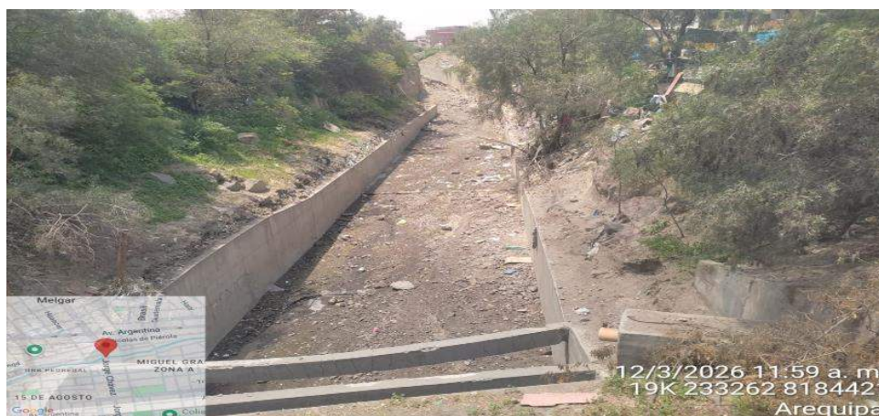
IMAGEN 02: SE OBSERVA LA COLMATACION Y EL CAMBIO DE ALTURA DEL MURO ASI COMO DOS ESTRUCTURAS TRANSVERSALES BAJAS EROSIONADAS POR LA MAXIMA AVENDIA DISMINUYENDO LA ALTURA DEL TIRANTE POR DONDE PASA EL AGUA.
